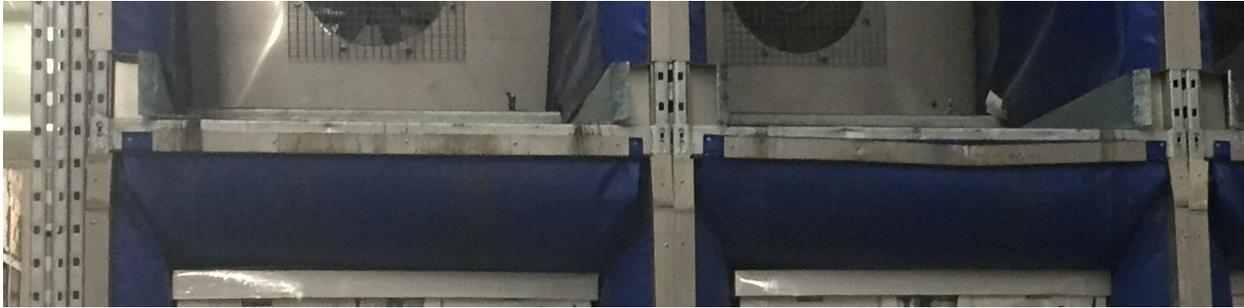
[24] D'une part, on constate des salissures sur la traverse horizontale qui sépare les deux rangées de cellules, que M. Peynet attribue au contact répété avec les mâts des chariots élévateurs utilisés pour déplacer les palettes de produits. D'autre part, on constate que la traverse au-dessus de la cellule de droite (la cellule n° 2) est déformée, ce qui suggère qu'elle a été accrochée par un objet.
