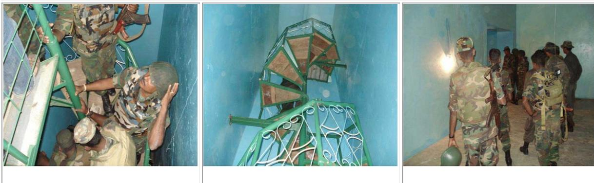
**Le bunker a une profondeur de 45 pieds et des murs en béton de 1,5 pied d'épaisseur. On trouvait également à l'intérieur du bunker une salle de réunion entièrement aménagée.**
